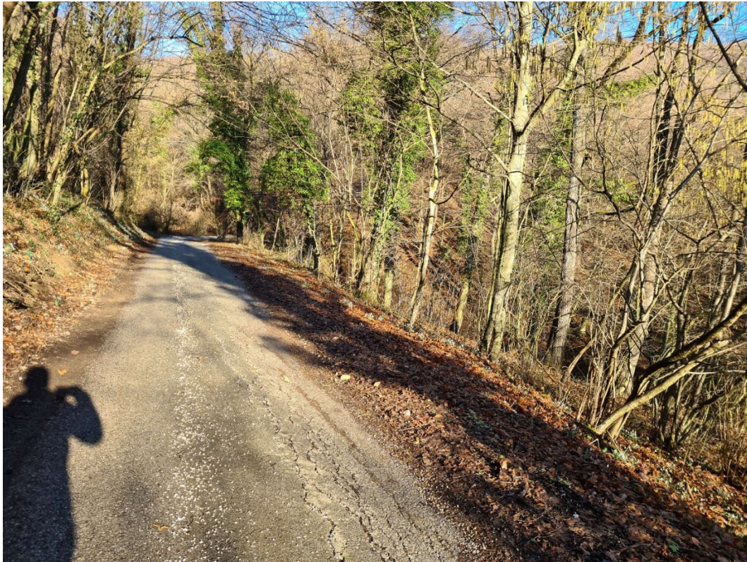
Slika 15 Pogled prema kraju lokacije (vidljivo proširnje bankine)
