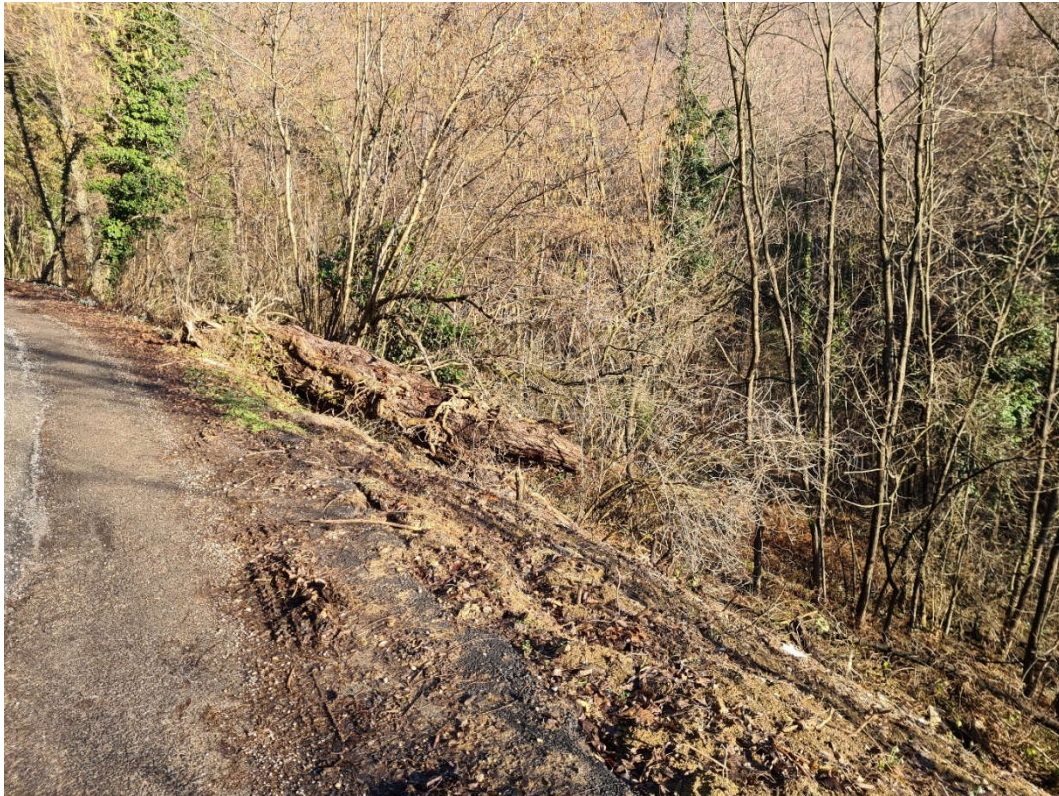
Slika 11 Odložen materijal iz iskopa na pokos zasjeka
