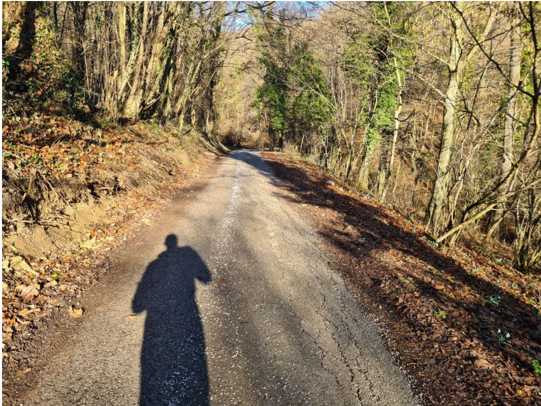
Slika 13 Uzdužne mrežaste pukotine i na drugom dijelu lokacije (proširnje bankine)
